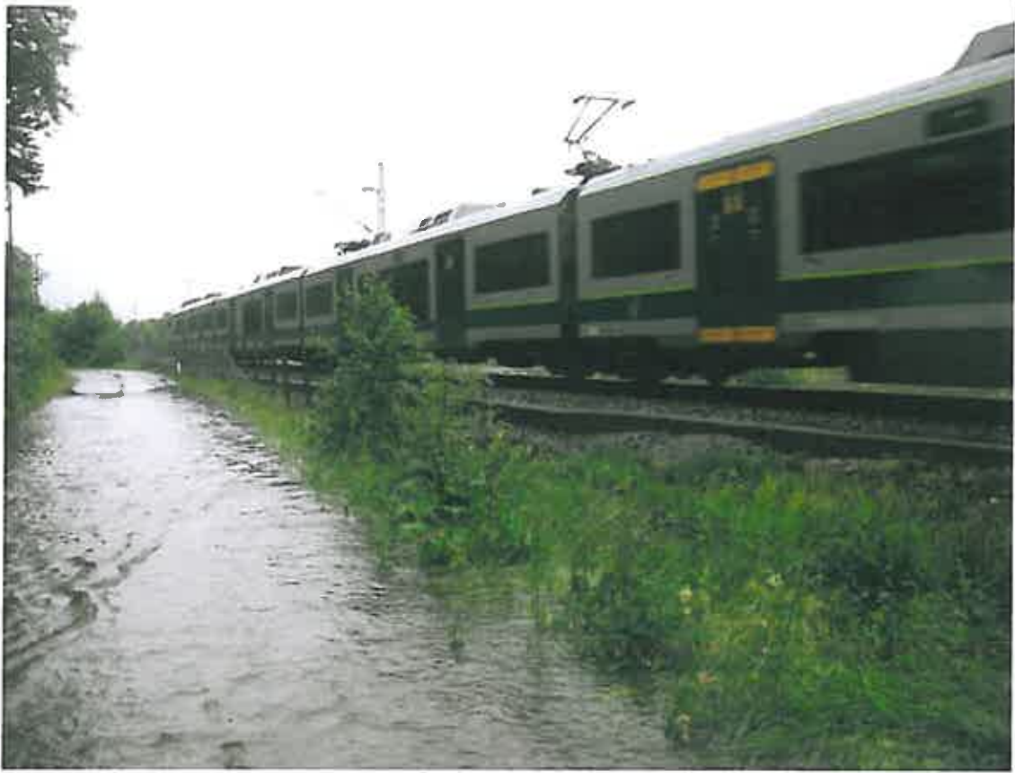
Fig 2. Underlandsveien mellom Asker og Røyken sto under vann 4. juli 2007 etter kraftig nedbør. Det var fortsatt klaring til Spikkestadbanen. Foto: Jonas Vevatne (/12/)
