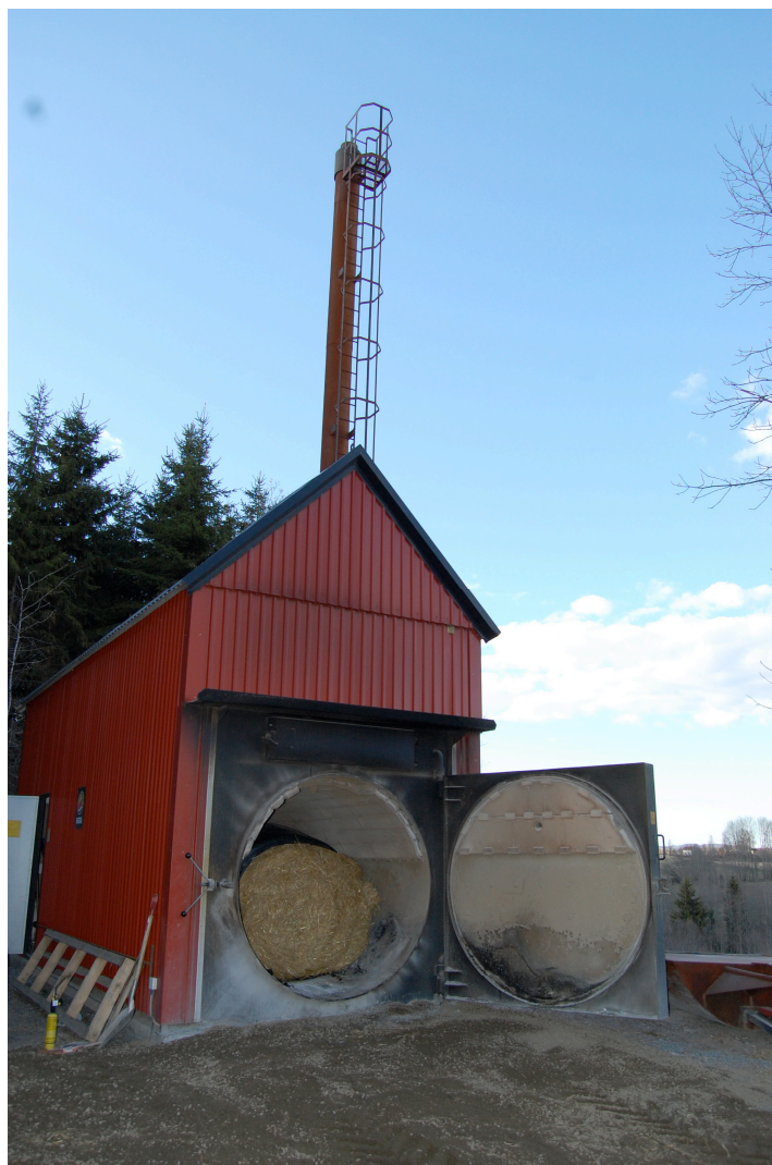
Figur 3-8. Halmforbrenningsanlegg for rundballer. [Foto: Helge B. Pedersen]
