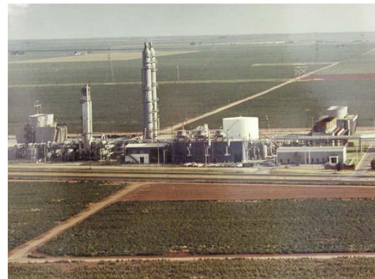
Lubbock, Texas 1980 Gasskraftverk med CO2-fjerning
